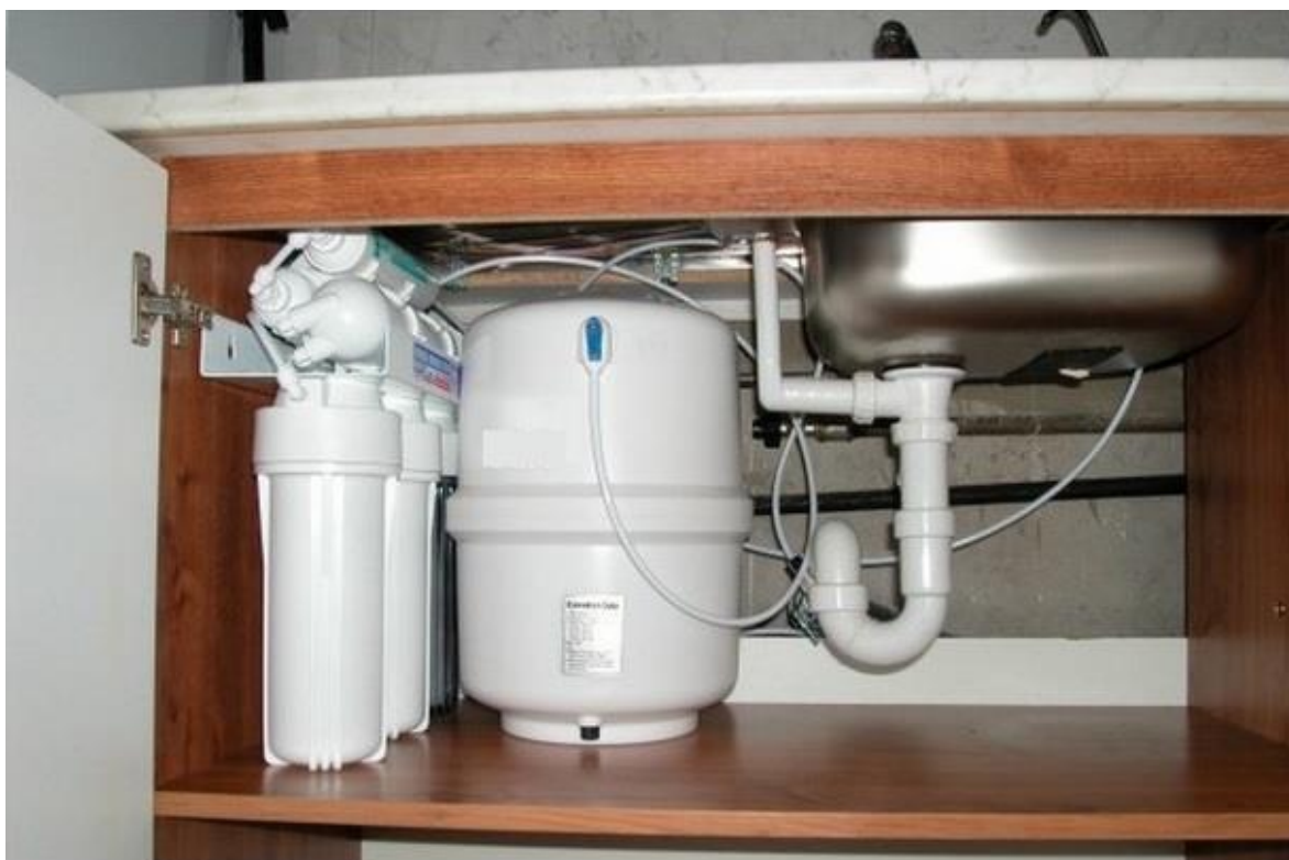
PŘÍKLAD UMÍSTĚNÍ SYSTÉMU FILTRŮ REVERZNÍ OSMÓZY S NÁDRŽKOU POD KUCHYŇSKÝM DŘEZEM
